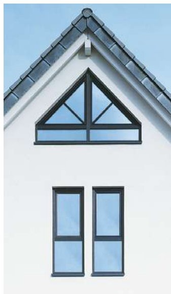
Dei traversi montati orizzontalmente sostengono la parte centrale e creano maggiore ampiezza dal punto di vista visivo.
